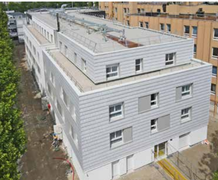
↑ Logements en construction modulaire bois pour Adoma, à Sartrouville (78) ITAR Architectures
