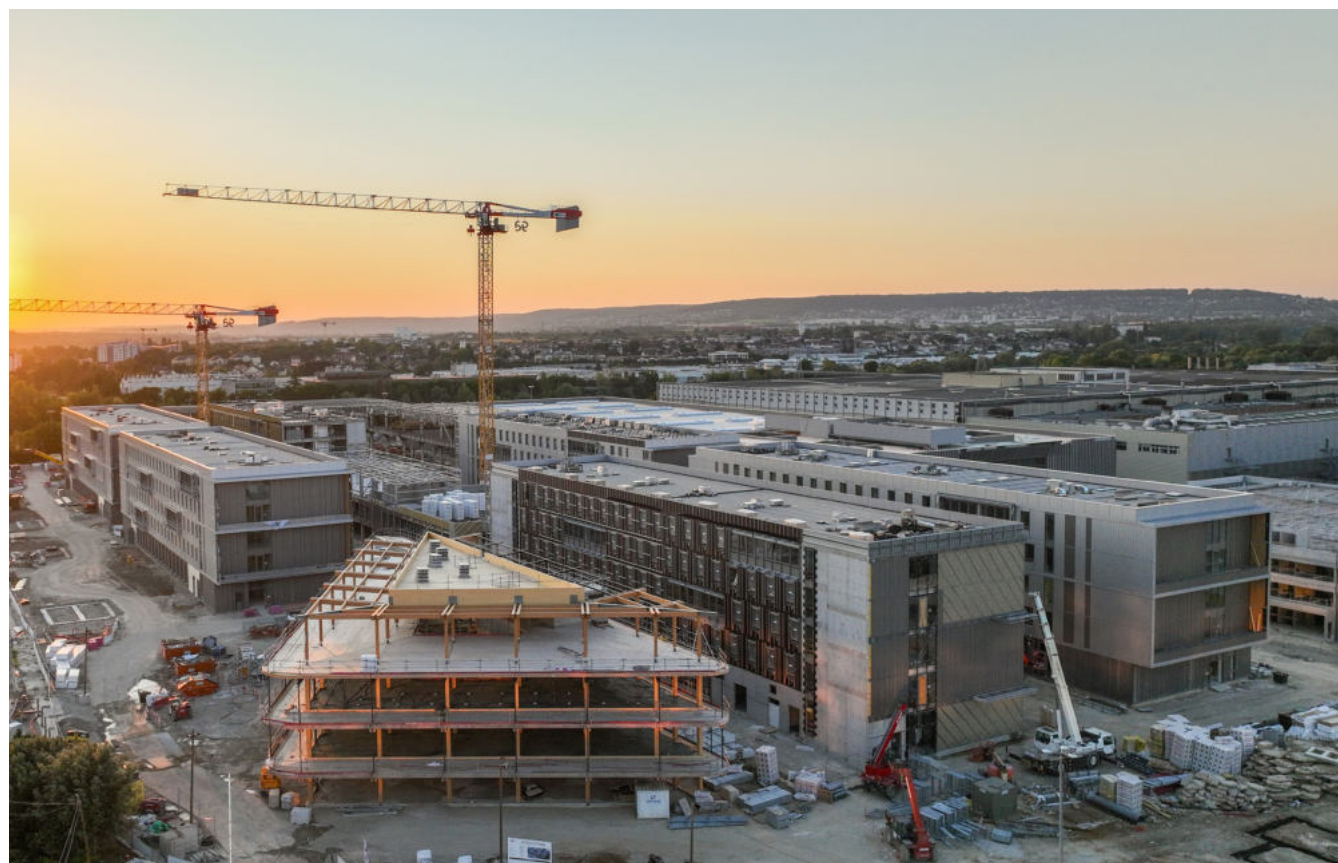
↑ Chantier du futur grEEn-campus de Stellantis - Potion Média
