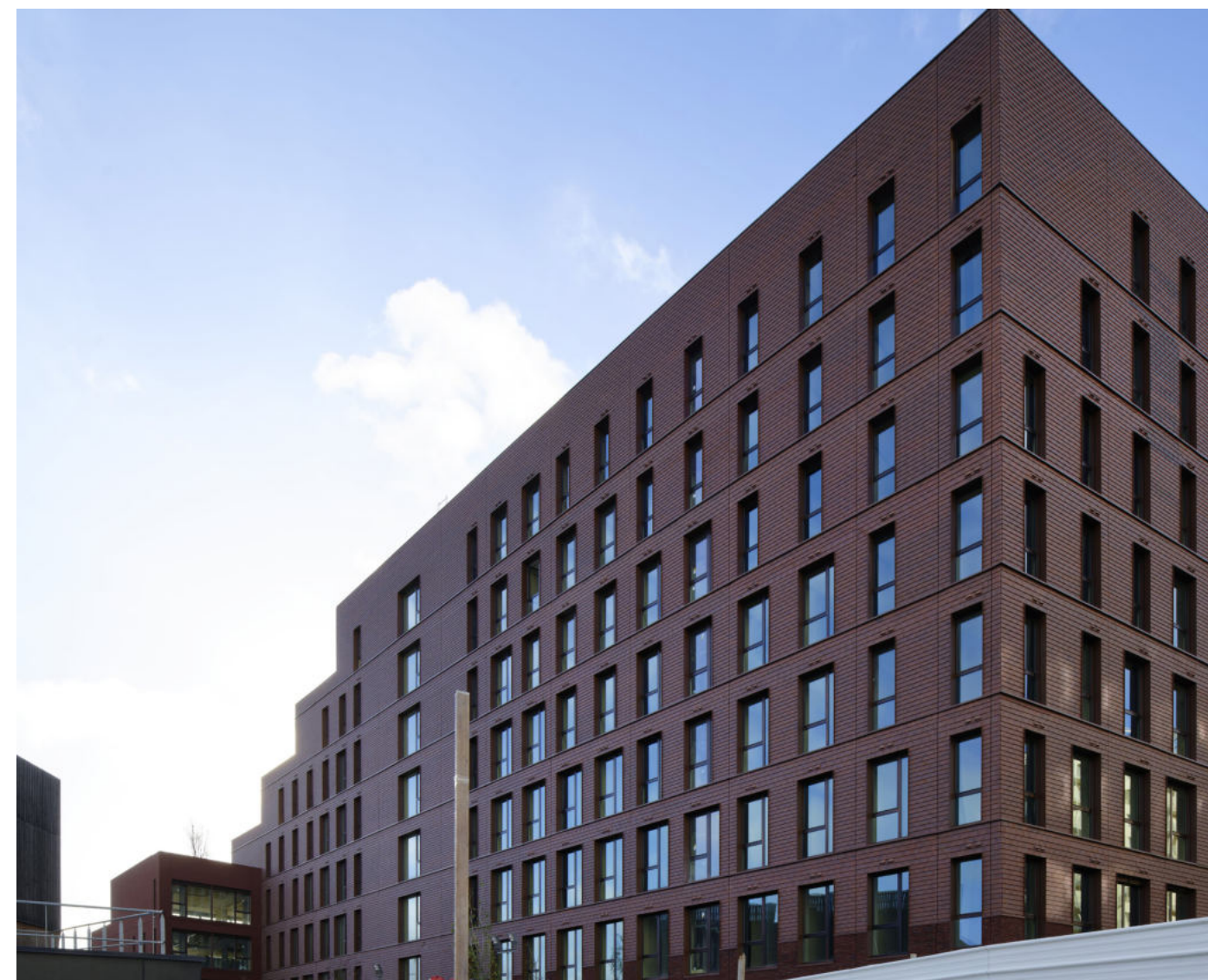
↓ Les Gradins, immeuble de bureaux réversibles , à Saint-Ouen (93) - Augusto Da Silva
